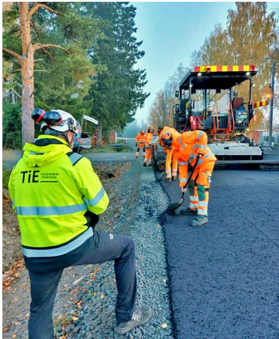
➤ Tieisännöitsijä Ari Eteläniemi valvoo asfaltointityömaata.
