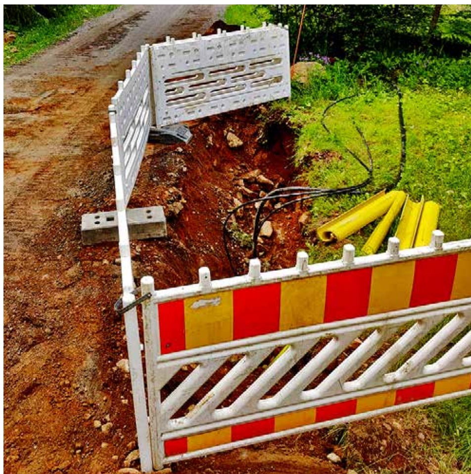
➤ Kaapeli sijoitetaan metrin syvyyteen.
