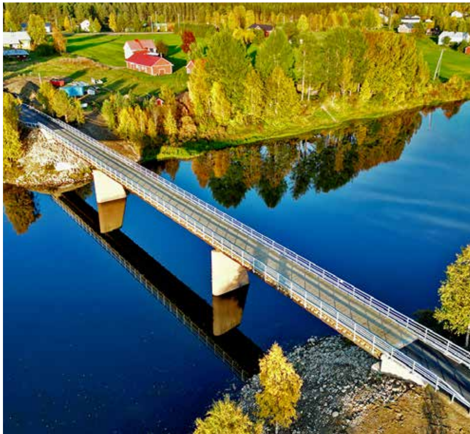
➤ Tenniöjoen uusi silta ilmasta kuvattuna.
