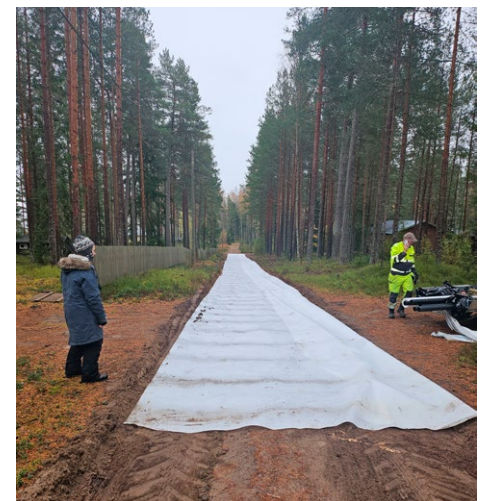
➤ Tiesännöitsijä Mika Eronen levittämässä suodatinkangasta ja osakas Tua Karlsson valvomassa.
